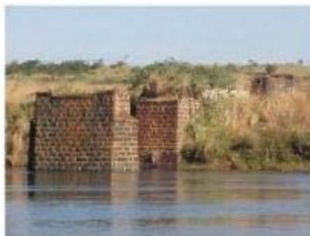
Antigas pilastras da Ponte Afonso Pena.
