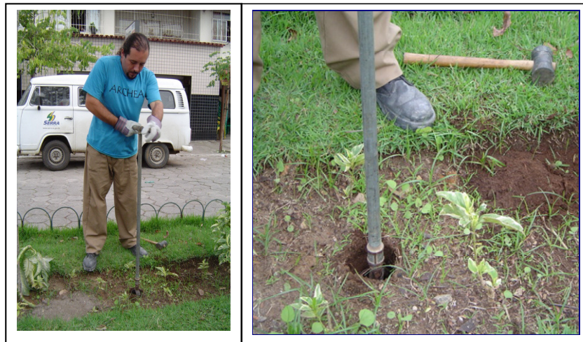
Figura 4-5: Detalhe de abertura manual de um furo de amostragem.
