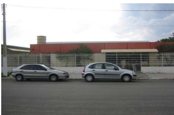
Fig. 4 – Fachada Creche do Lelé em Niterói (Foto cedida pelo GAE)
