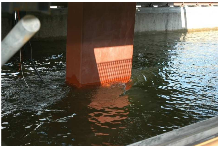
Figura 7.4: Detalhe do tubo de vácuo
