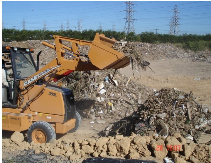
Figura 4.5: Formação de nova de pilha de ENTUV-ES após quarteamento
