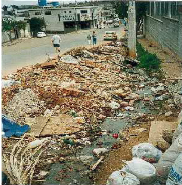
Figura 3.6: Disposição irregular de RCC's em logradouro público em Diadema - SP Fonte: Pinto (1999)
