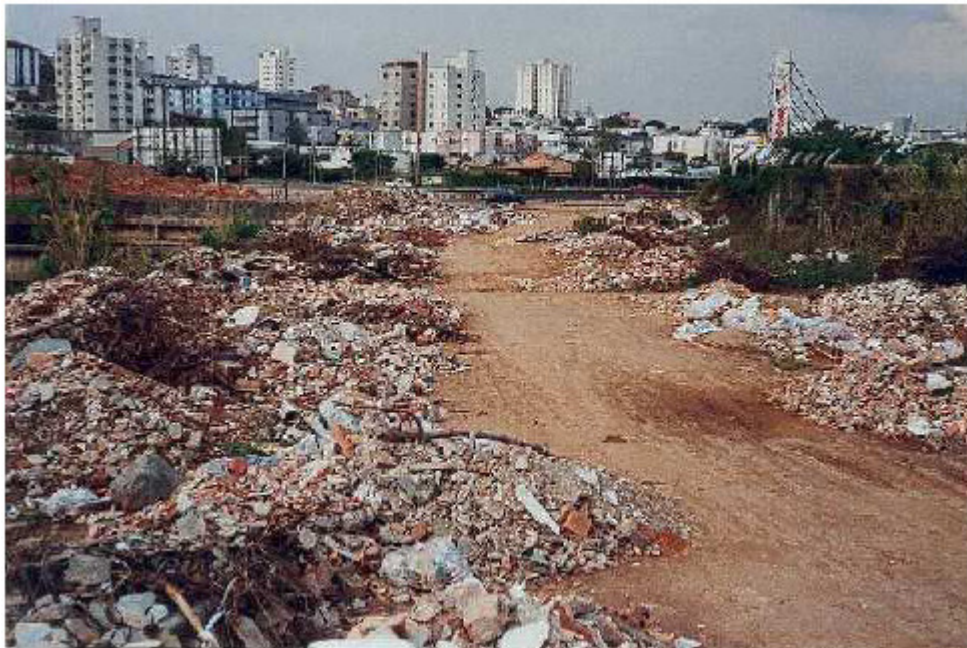
Figura 3.3: Disposição irregular de RCC's em Belo Horizonte - MG Fonte: Pinto (1999)
