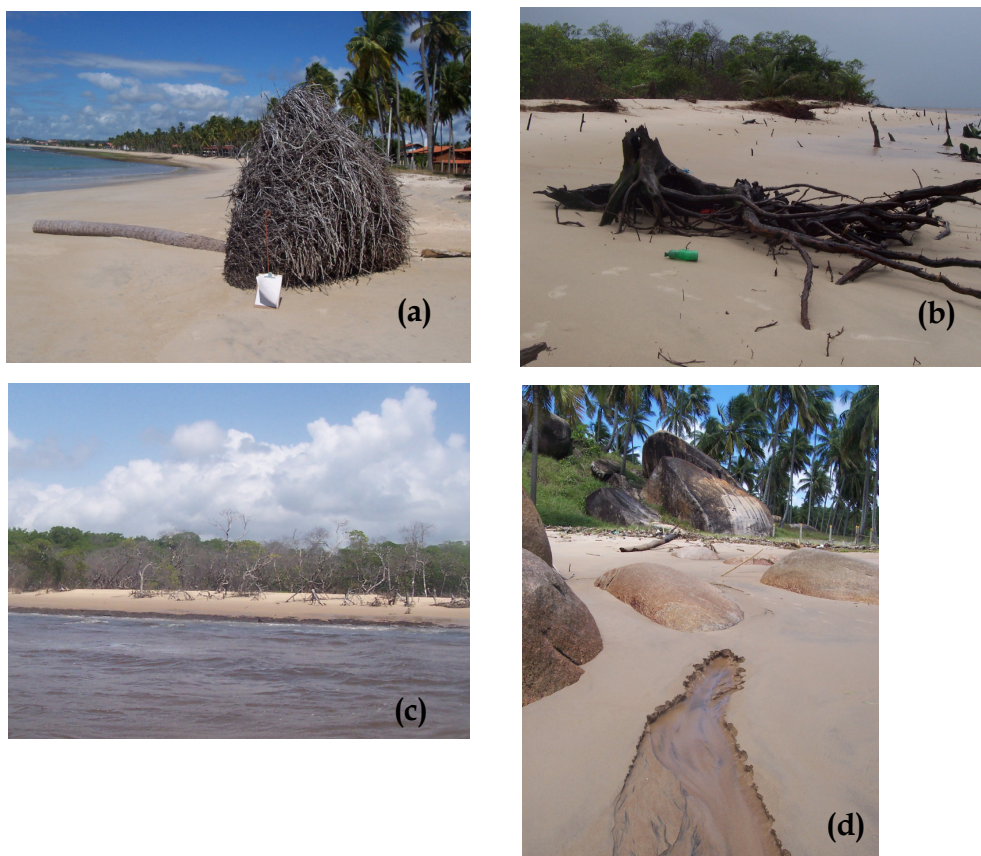
Figura 50 - Indicadores de erosão: (a) raiz de um coqueiro caído no Pontal de Manguinhos; (b) mangues caídos e (c) afloramento de turfa no complexo estuarino Ilhetas-Mamucabas e (d) afloramento do lençol freático na praia do Porto.
