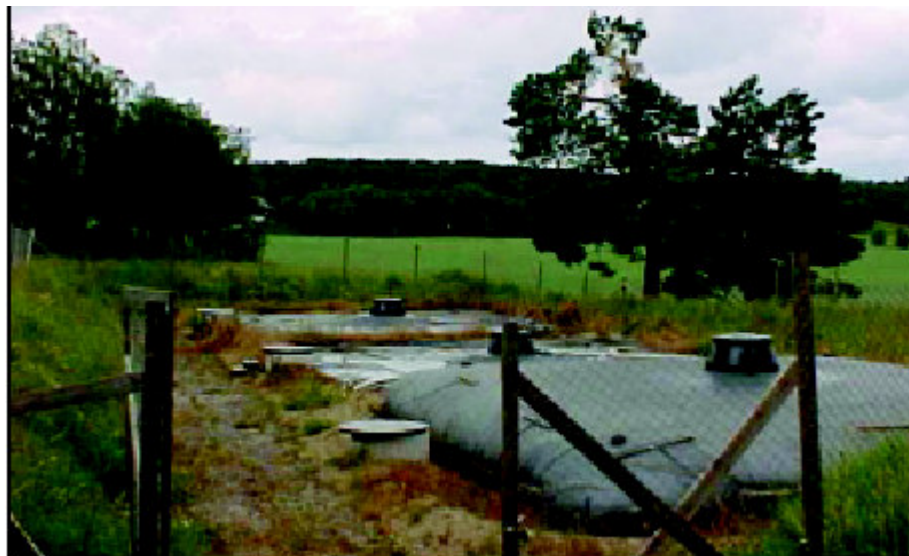
Figura 3- 10: Tanques de estocagem de urina. Fonte: JOHANSSON, 2000.
