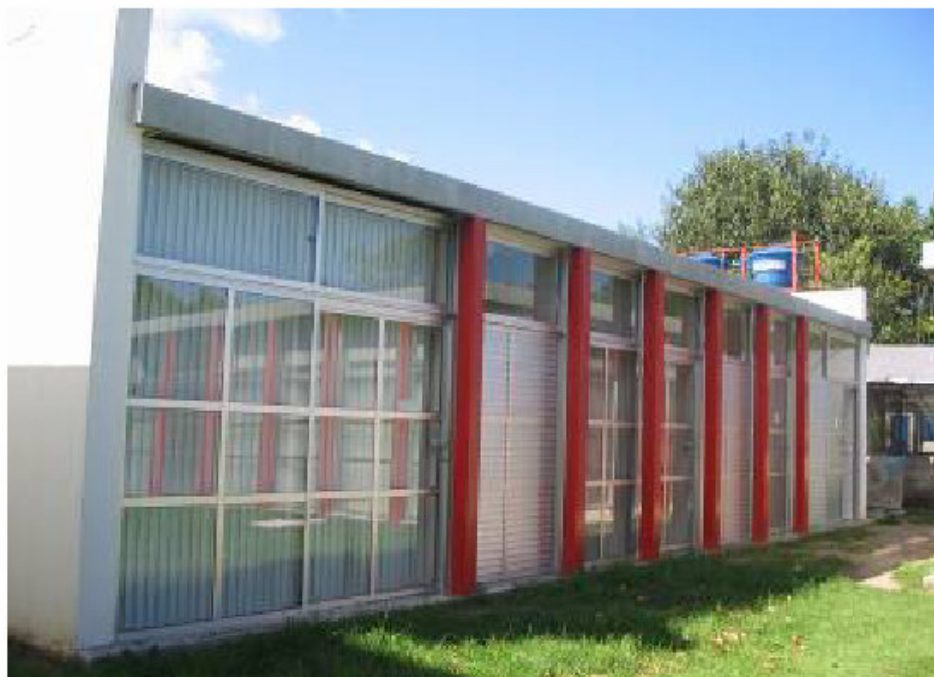
Figura 4-1: Prédio localizado no Parque Experimental do Núcleo Água.
