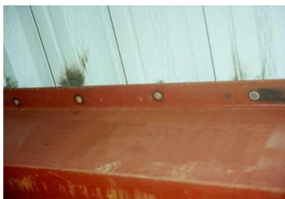
(c) mesas perfuradas – chapa de 6,3 mm e *stud* com 19 mm de diâmetroFIGURA 2.8 – Danos nas chapas decorrentes da soldagem de *studs* (fotos do autor).
