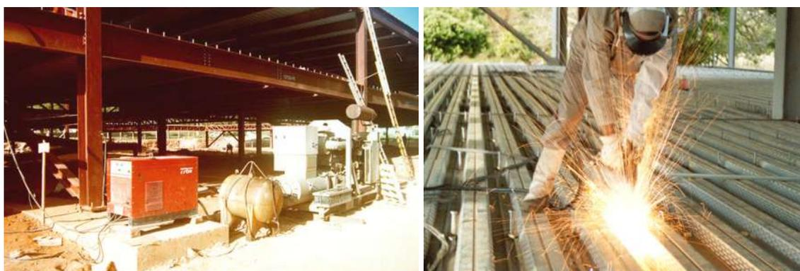
FIGURA 2.7 - Sistema para soldagem de conectores *stud* (fotos do autor).
