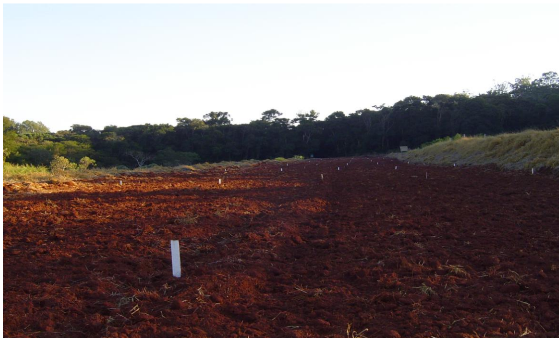
Figura 3 – Vista da pista 1 - superfície mobilizada
