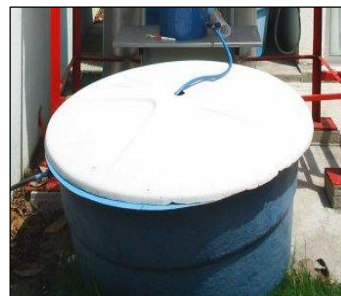
Figura 4.6 . Reservatório de armazenamento da água da chuva (pré - tratamento)
