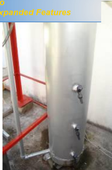
Figura 4.16 A e B: Filtro lento de arêa.
