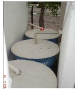
Figura 4.6 . Reservatório de armazenamento da água da chuva (pré - tratamento)
