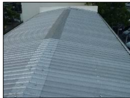
Figura 4.2 . Telhado de coleta da água de chuva
