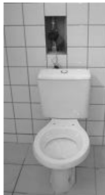
Figura 39 – Hidrômetro instalado no prédio do Parque Experimental do Núcleo Água
