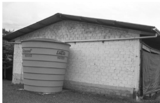
Figura 22 – Reservatório de polietileno
