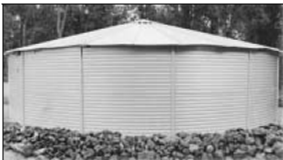
Figura 21 – Reservatório de aço
