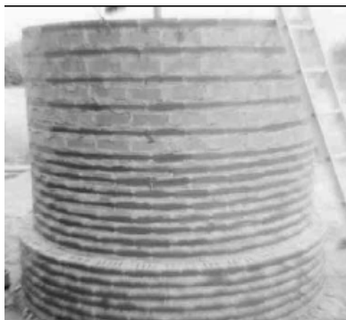
Figura 19 – Reservatório em alvenaria
