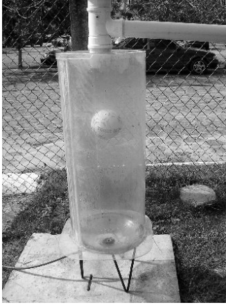
Figura 29 – Reservatório de Eliminação de Primeira Chuva
