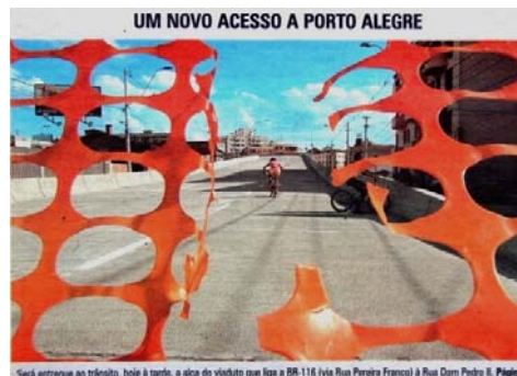
Serviço entregue ao tráfego, hoje à tarde, o alça de viaduto que liga a BR-116 (via Rua Pereira Franco) à Rua Dom Pedro II. Página 3 Capa, 19/12/05, Mauro Vieira
