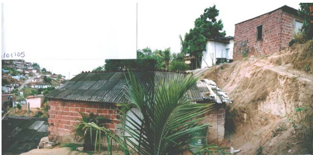
ILUSTRAÇÃO 78: Casa invade fundo de lote formal fazendo cortes perigosos, seus moradores estão no auxílio-moradia. Fonte: foto da autora, 2005.
