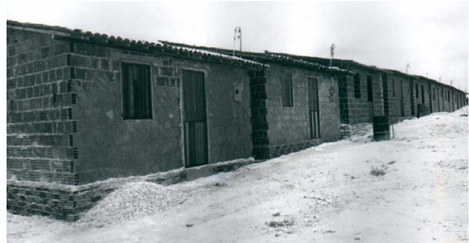
ILUSTRAÇÃO 40: As primeiras casas, ainda sem infra-estrutura urbana. Fonte: Selma Arteiro, [1990?].
