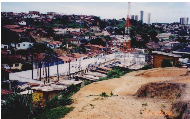
ILUSTRAÇÃO 76: Invasão da subestação da CELPE. Fonte: foto da autora 2003
