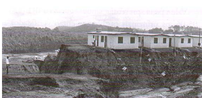
ILUSTRAÇÃO 19 e 20- Conjunto Santa Etelvina da COHAB/SP em fase final de construção e detalhe, do processo erosivo que quase destruiu o conjunto. Fonte: FREITAS ET AL, 2001 e FARAH, 2003 (detalhe).
