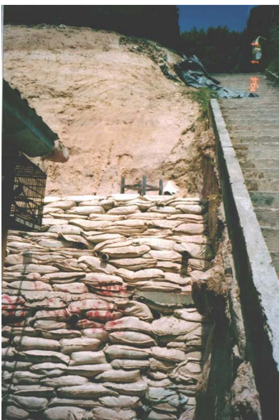
ILUSTRAÇÃO 62: contenção RIP-RAP em execução. Fonte: foto da autora, 2005.
