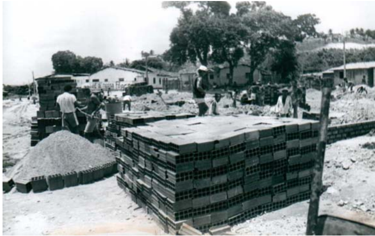
ILUSTRAÇÃO 39: Canteiro organizado para facilitar o controle de material, os técnicos da COHAB acompanhavam todo o processo. Fonte: Selma Arteiro, [1989?].
