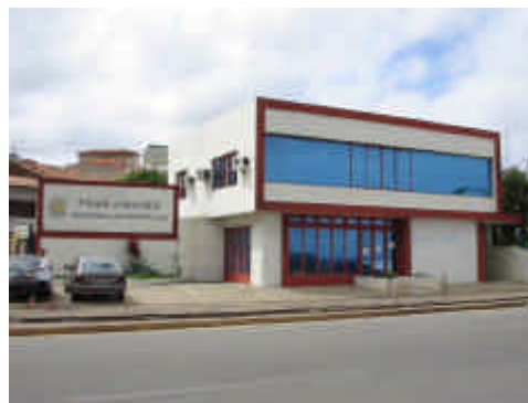
Figura 44: Prédio contemporâneo, na Beira-Mar. Fonte: Autora, 2003.
