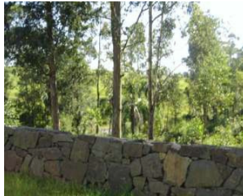
Muro de pedra e massa vegetal
