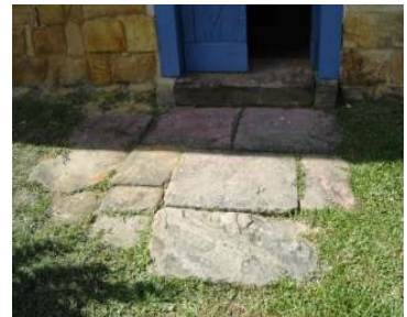
Detalhe na entrada principal
