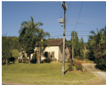
Acesso à edificação
