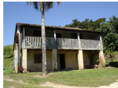
Figura 33: Cantina parcialmente escavada com entrada frontal. Propriedade de Francisco de Assis Ceron, localidade de Rio Carvão, em Urussanga. Fonte: Luca, 2006.
