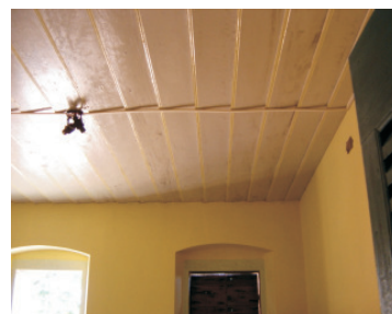
Detalhe do forro
