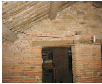
Alvenaria aparente e estrutura da esquadria
