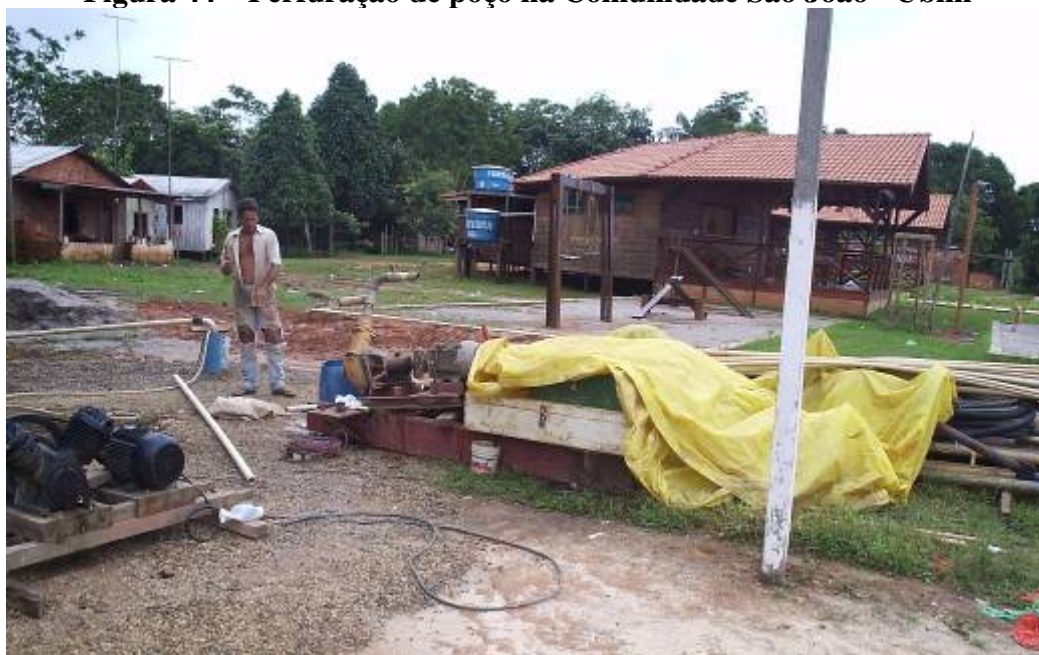
Figura 44 – Perfuração de poço na Comunidade São João - Ubim
