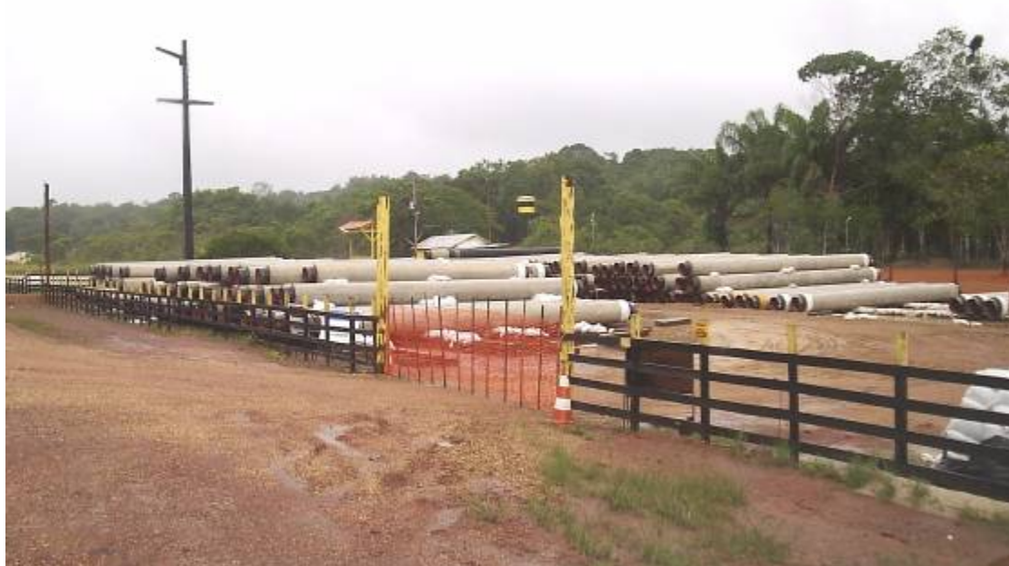
Figura 43 – Terreno alugado para guardar os tubos
