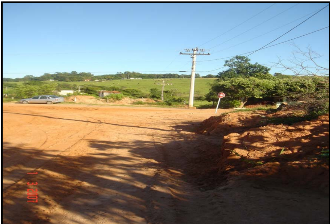
FIGURA 19 – Estrada de terra Municipal (GET 020) que transporta sedimentos para o Córrego Gavanhery (próximo aos pontos 3 e 4)
