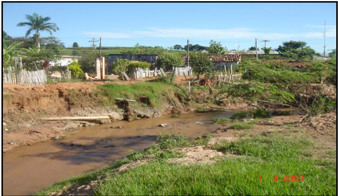
FIGURA 17 - Lançamento de esgoto doméstico clandestino no Córrego Gavanhery (montante ao ponto 3)
