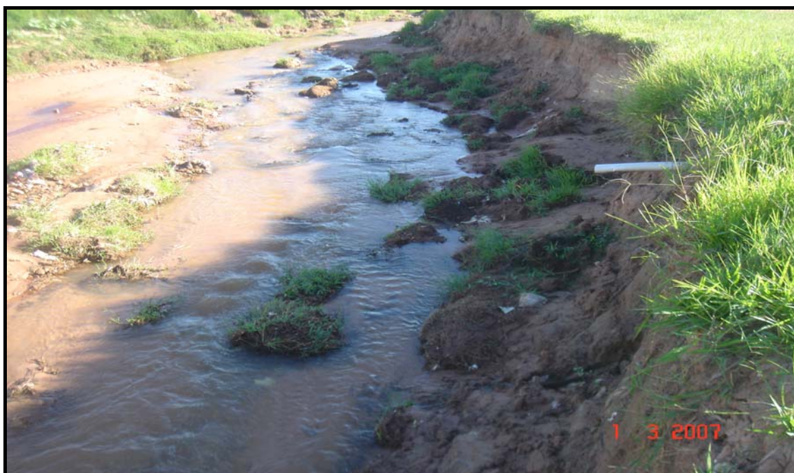
FIGURA 15 – Lançamento de esgoto clandestino (jusante ao ponto 4)
