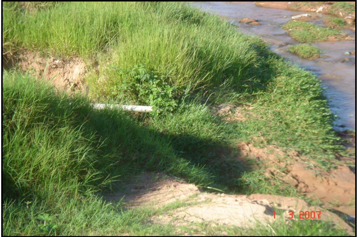
FIGURA 18 - Lançamento de esgoto doméstico clandestino no Córrego Gavanhery (jusante ao ponto 4)
