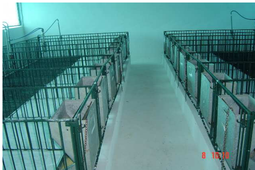
FIGURA 1 - Instalações da Creche
