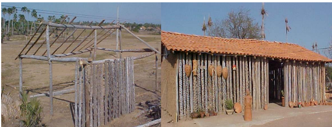
Figura 8 – Construção civil com a carnaúba Fonte: A autora (2007)
