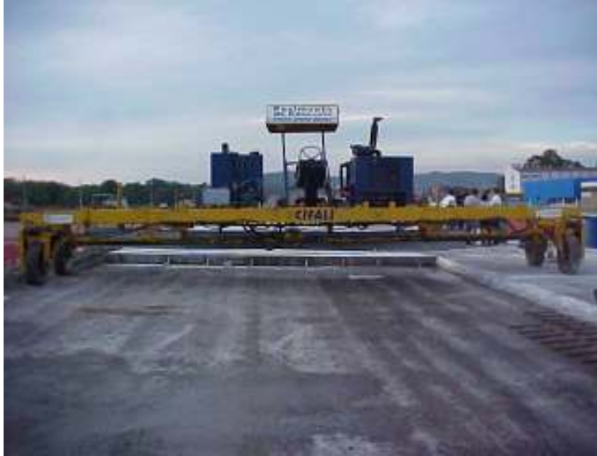
Figura 4 - Equipamento utilizado no Rodoanel de São Paulo
