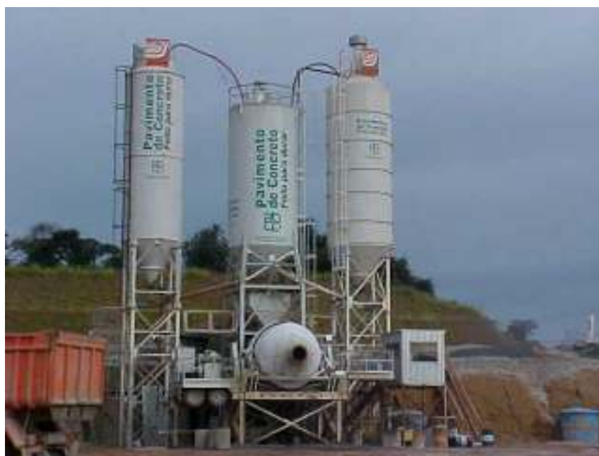
Figura 2 - Central de concreto
