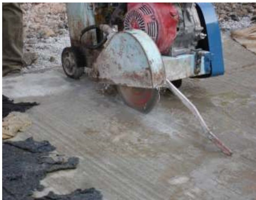
Figura 6 - Corte de juntas
