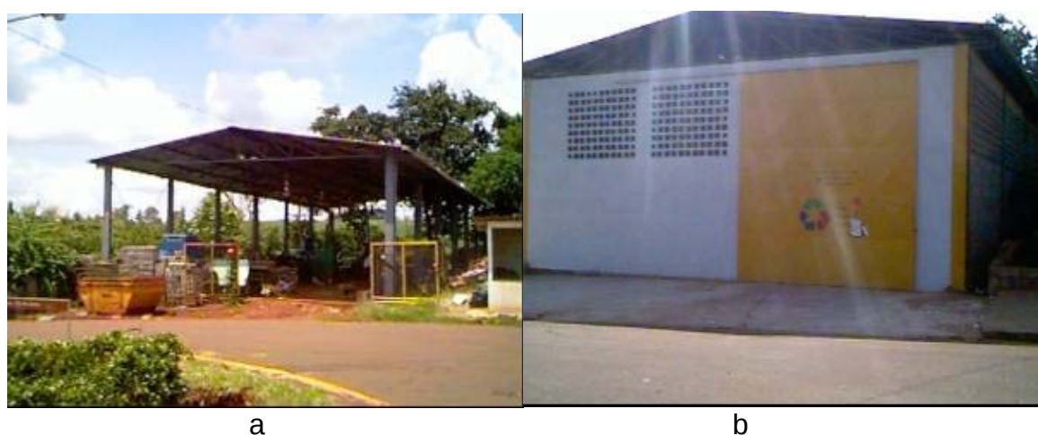
Figura 5.5 Barracão de Triagem da antiga Área de Coleta Seletiva da UNICAMP, antes de seu fechamento em janeiro de 2.001 (a) e em 2008 (b)
