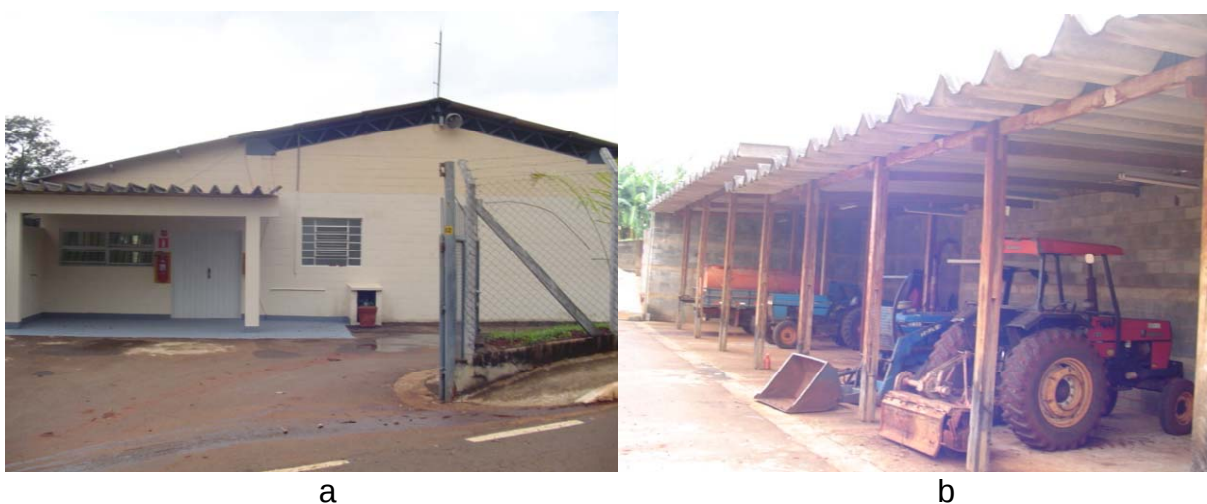
Figura 5.8 Barracão da DAV/UNICAMP (a) e sua garagem de máquinas (b)
