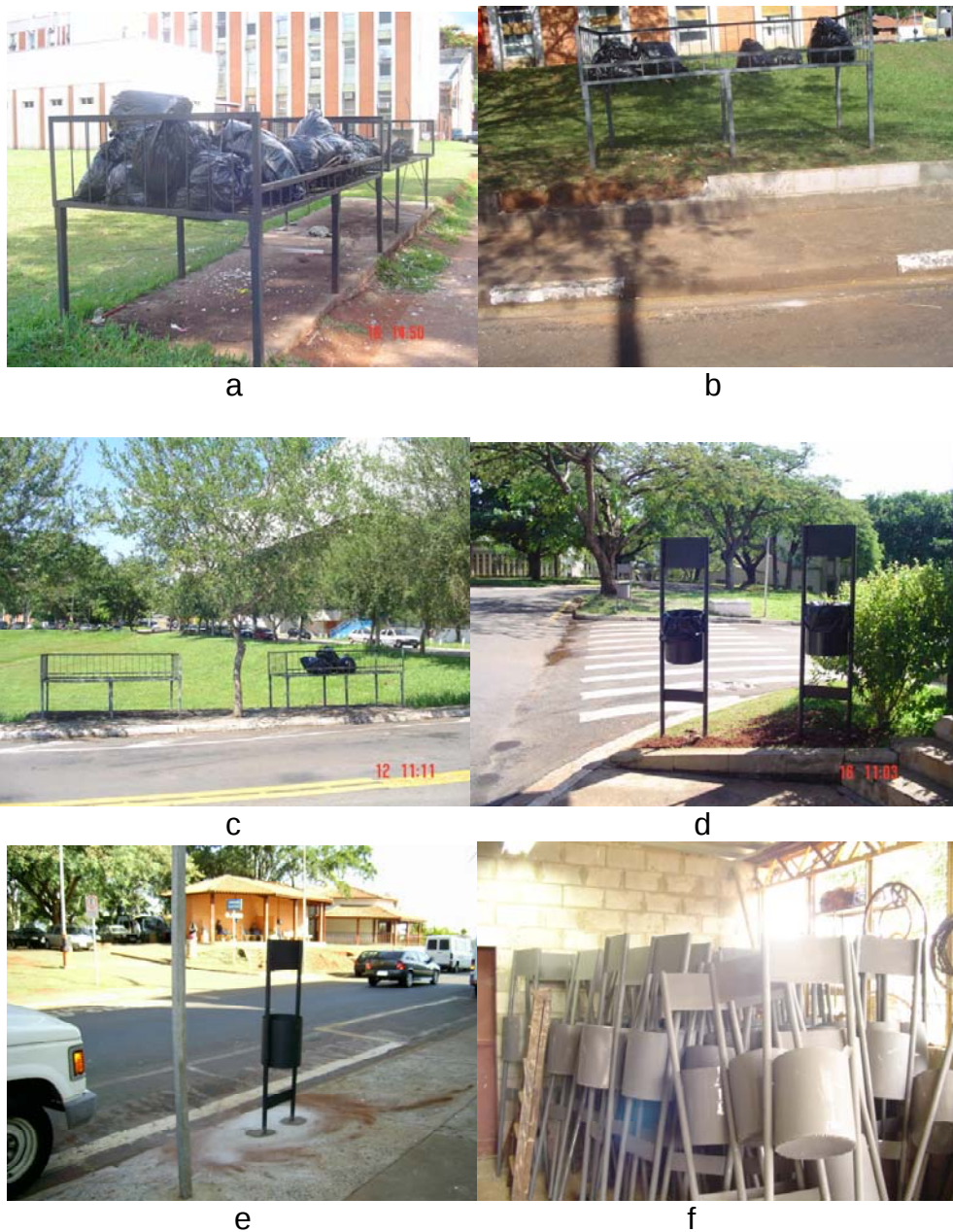
Figura 5.9 Grade de lixo (a, b e c) e lixeiras fixas de ferro (d, e e f ) instaladas e a serem instaladas no Campus Cidade Universitária “Zeferino Vaz” da UNICAMP
