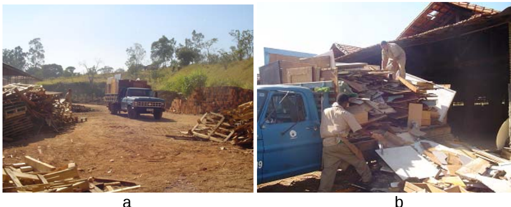
Figura 5.35 Resíduo de Madeira gerado no Campus Cidade Universitária “Zeferino Vaz” da UNICAMP chegando à cerâmica no Bairro do Guará (a) e sendo descarregado no depósito da cerâmica (b)
