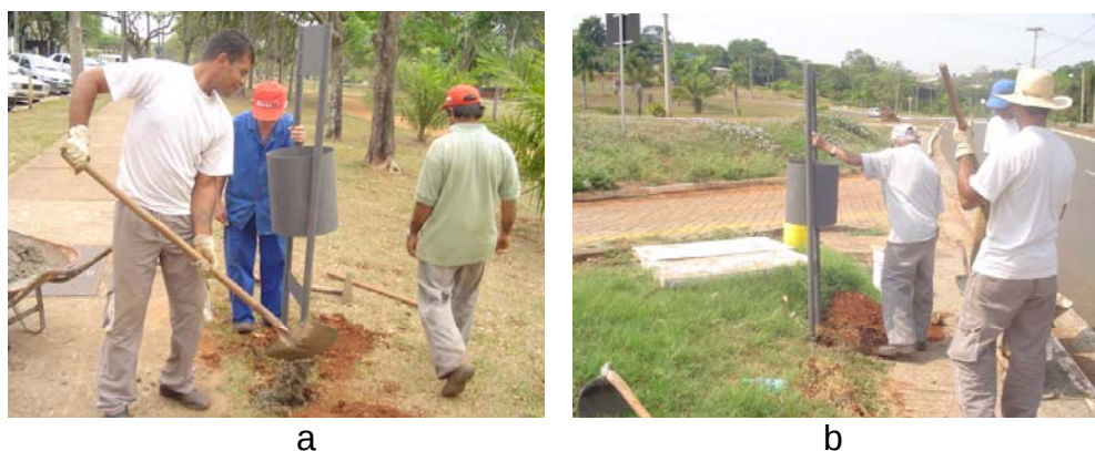
Figura 5.42 Instalação de lixeiras na Praça da Paz (a) e na Av. Antonio Costa Santos (b) no Campus Cidade Universitária “Zeferino Vaz” da UNICAMP
