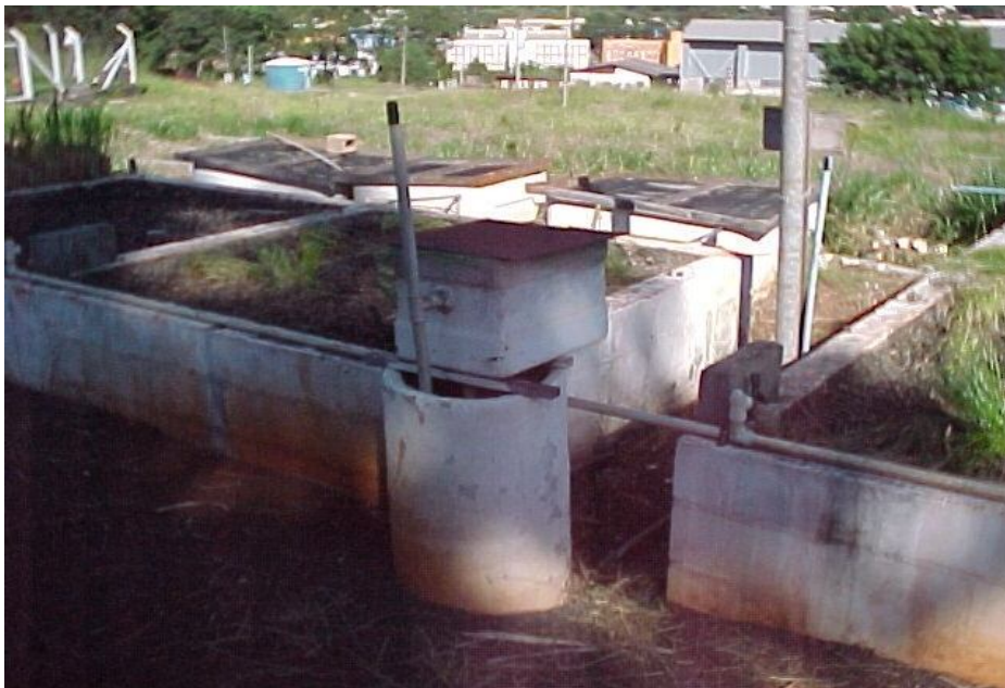
Figura 4.4 - Divisor de vazão do leito cultivado.
