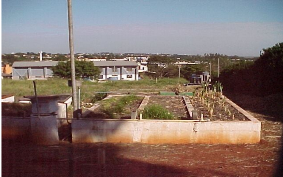
Figura 4.6 - Leito cultivado retangular com as macrofitas em estágio inicial.
