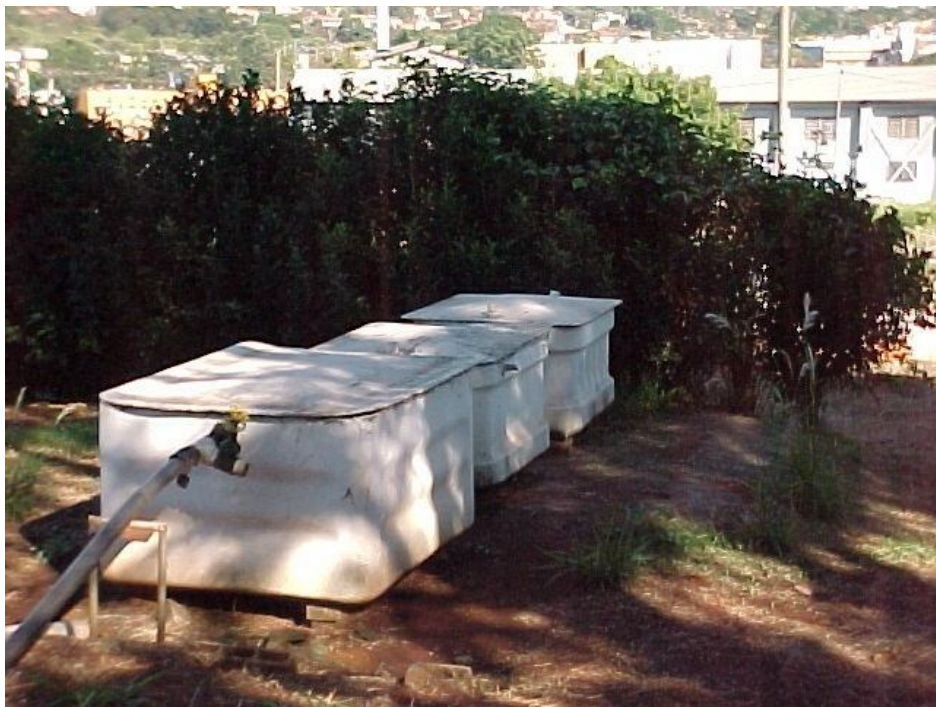
Figura 4.3 - Tanque séptico modificado.
