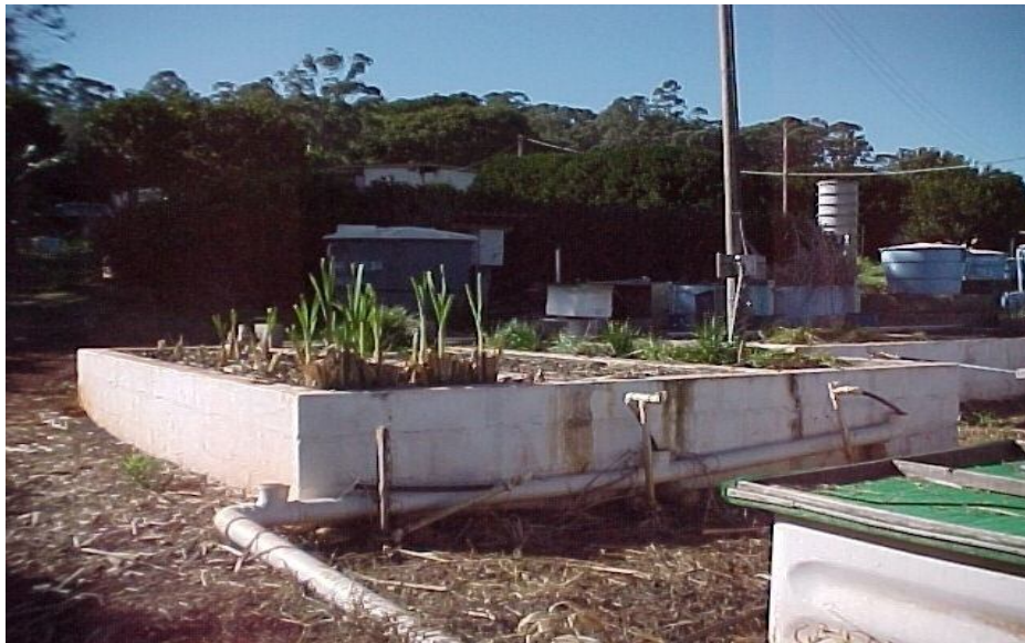
Figura 4.7 - Sistema de drenagem do leito cultivado.
