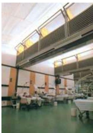
FIGURA 4.20 - Enfermaria do Hospital Sarah Kubistchek de Salvador - Ventilação e iluminação natural. Fonte: LATORRACA, 1999.
