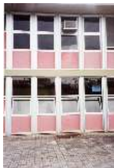
FIGURA 6.7 Aberturas das fachadas do Hospital Infantil
