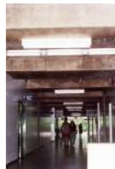
FIGURA 6.11 - Aberturas zenitais na circulação do ambulatório
