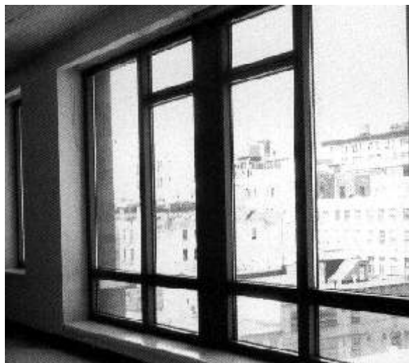
FIGURA 5.6 - Janela do quarto de internação da Unidade Pediátrica do Hospital New York- limite inferior da abertura próximo ao chão, adequando-se à escala da criança. Fonte: MALKIN, 1991.
