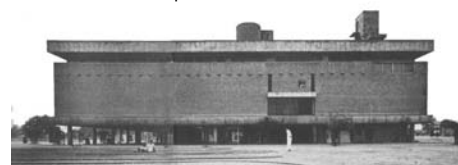
Fig. 131 – Museu de Ahmedabad, Índia, Le Corbusier, 1954-1956. Vista da fachada norte.
