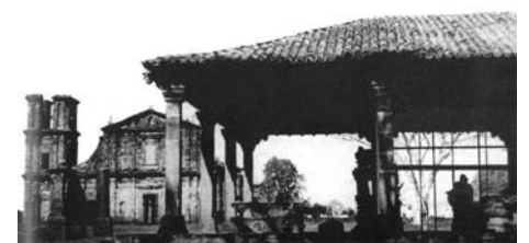
Fig. 158 – Museu das Missões, Lucio Costa, São Miguel das Missões, , 1937. Vista parcial com ruínas da Igreja de São Miguel ao fundo.
