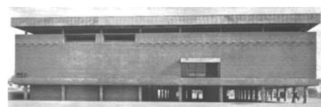
Fig. 133 – Museu de Ahmedabad, Índia, Le Corbusier, 1954-1956. Vista da fachada sul.
