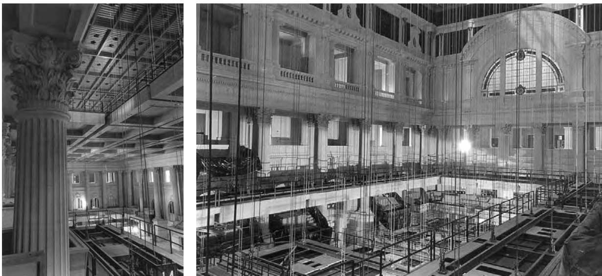
Figura 65 e 66 Forro móvel executado sobre a sala de concertos Fotos: Luiz Carlos Felizardo
