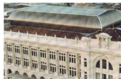
Figuras 62 e 63 Sala São Paulo Vistas interna e externa da cobertura em policarbonato Fonte: www.vitruvius.com.br
