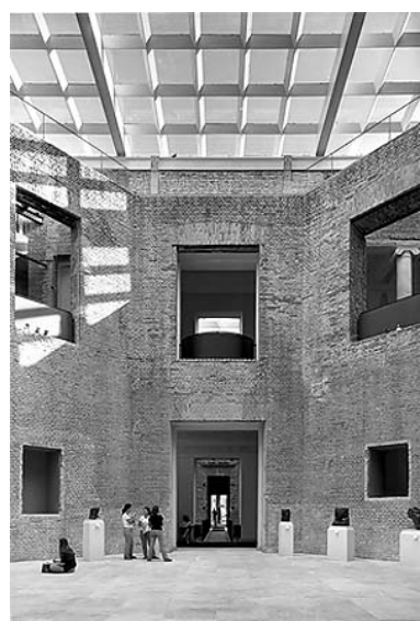
Figura 41 Pinacoteca de São Paulo Octógono central com a nova cobertura Vãos das janelas somente no osso. Foto: Nelson Kon
