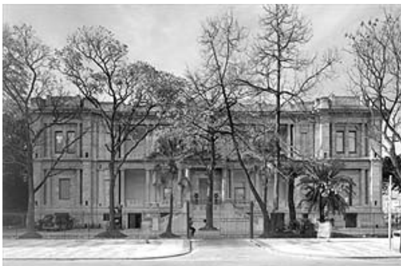
Figura 37 Pinacoteca de São Paulo Fachada da Av. Tiradentes anterior à intervenção Foto: Nelson Kon
