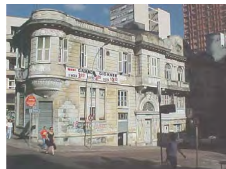
Figura 15 Ed. Tuiuti, Porto Alegre Prédio misto (comercial no térreo e residencial nos pavimentos superiores) a ser transformado para abrigar comércio/serviços. Foto: autor
