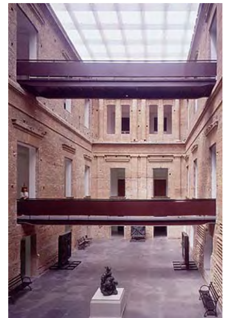
Figuras 43, 44 e 45 Pinacoteca de São Paulo Passarelas metálicas Fotos: Nelson Kon
