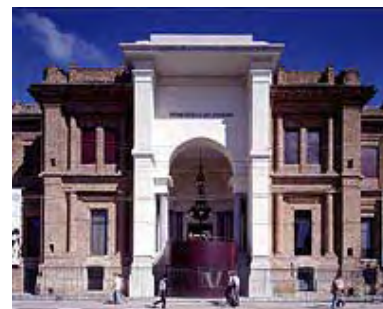
Figura 40 Pinacoteca de São Paulo Fachada da Av. Tiradentes, com o belvedere que substituiu a escada. Foto: Nelson Kon
