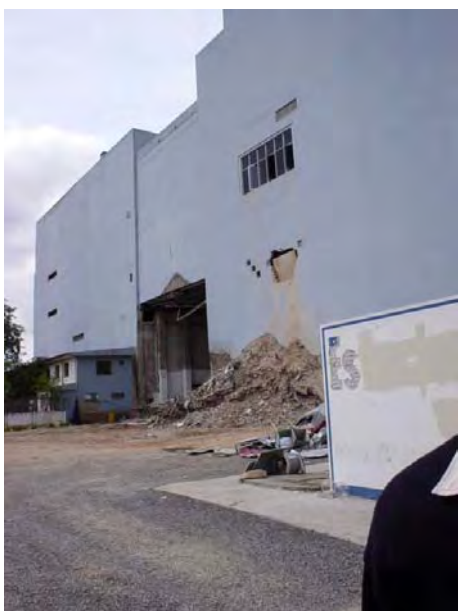
Figura 89 Demolição da Capela Nossa Senhor dos Passos São Leopoldo Foto: autor
