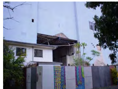
Figura 87 Demolição da Capela Nossa Senhor dos Passos – São Leopoldo Foto: autor
