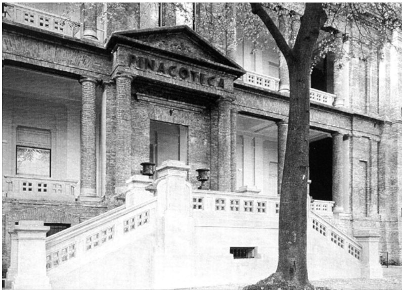
Figura 39 Pinacoteca de São Paulo Escada original suprimida pela intervenção Foto: Nelson Kon
