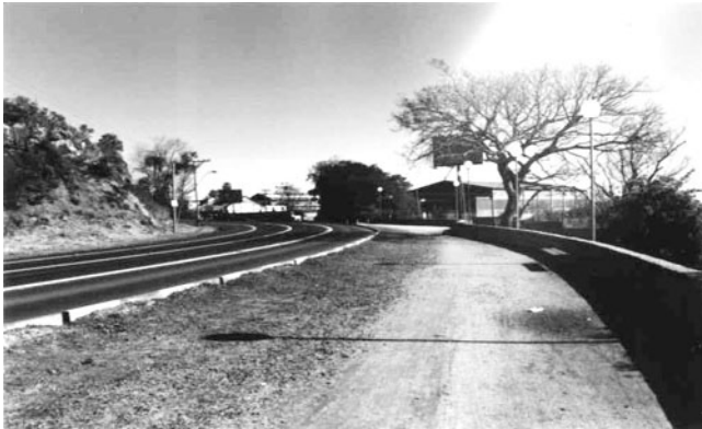
FIGURA 21 - Área contínua ao Museu Iberê Camargo com o estaleiro Só ao fundo.
