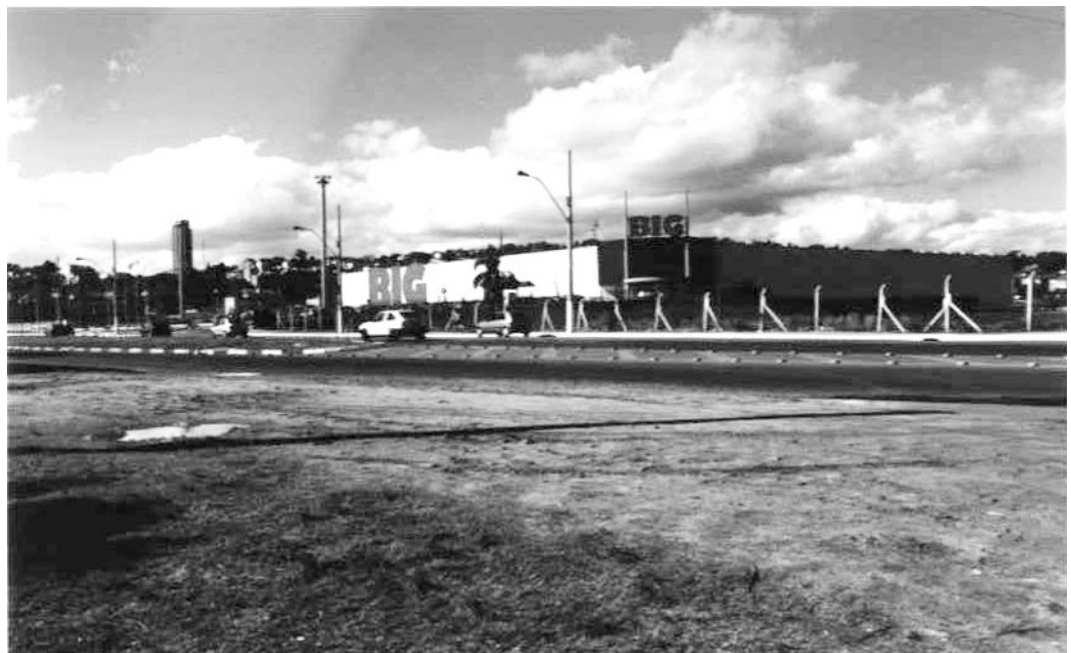
FIGURA 41 - Vista do aterro na frente do hipódromo do Cristal e do supermercado BIG .
