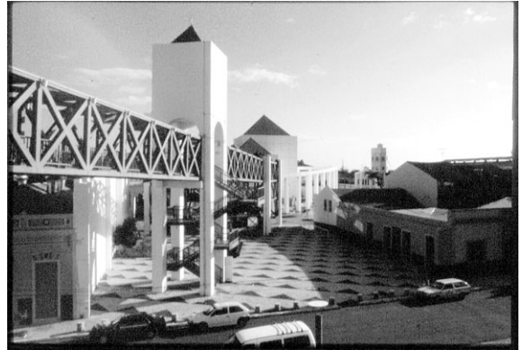
FIGURA 28 - Detalhe passarelas do Centro Cultural Dragão do Mar.
