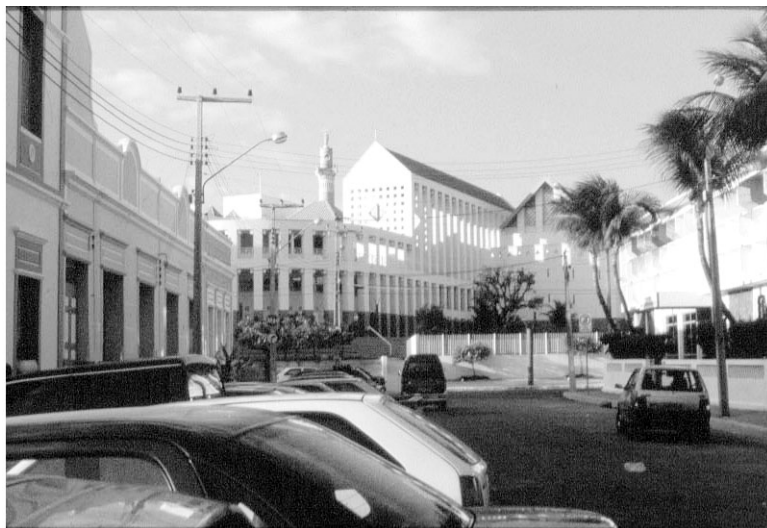
FIGURA 32 - Conjunto de sobrados e o Centro Cultural Dragão do Mar ao fundo.
