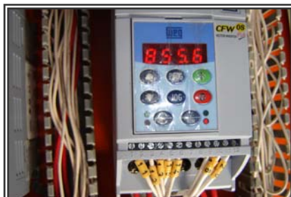
Ilustração 83 – Inversor de frequência – velocidade 855,6 rpm Fonte: Arquivo do autor
