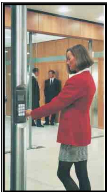
Ilustração 48 - Seleção do andar pelo passageiro antes de entrar no hall elevador.
