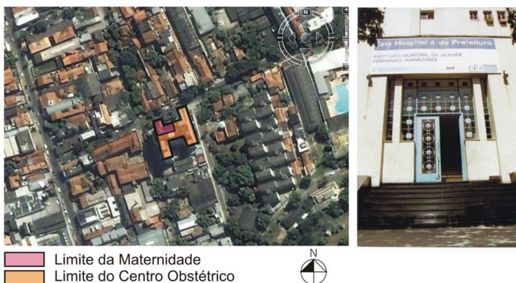
Figura 6.23 e 6.24 - Localização e fachada da Maternidade Fernando Magalhães. Fonte: Fábio Bitencourt, 2002; Google Earth, 2007.
