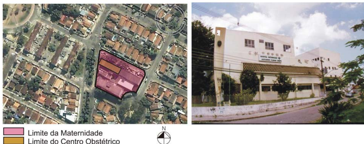
Figuras 6.11 e 6.12 - Localização e fachada da Maternidade Alexander Fleming. Fonte: Fábio Bitencourt, 2002; Google Earth, 2007.
