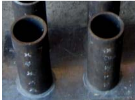
Figura 28 - Fixação dos tubos na chapa metálica por meio de silicone
