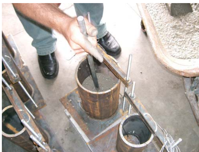
Figura 21 - Moldagem dos Pilares Mistos
