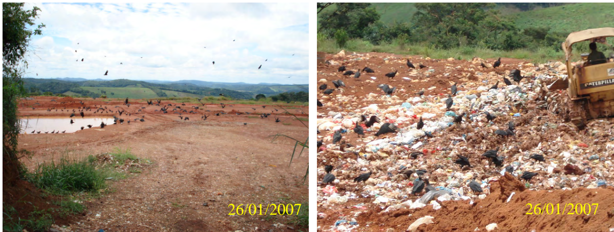
Figura 21 – Condições ambientais do aterro sanitário de Viçosa
