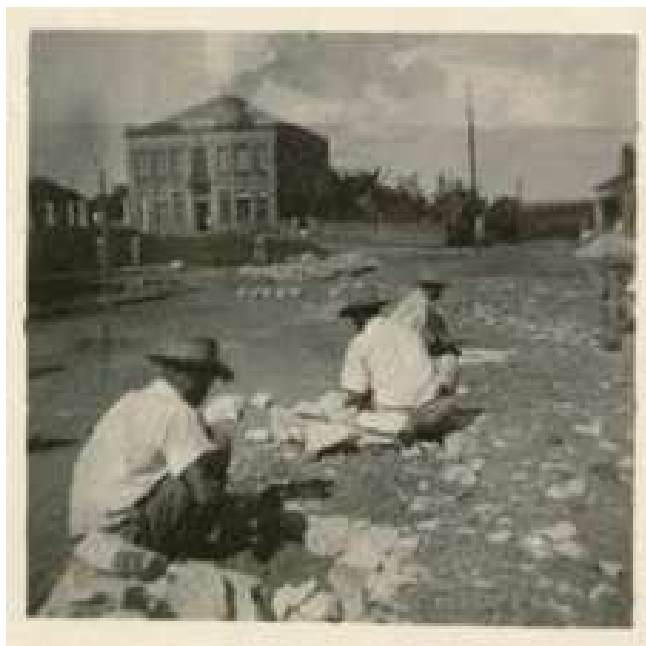
Figura 5: Trabalhadores da obra da nova matriz e de sua praça. Ao fundo vê-se o antigo Fórum. Início do séc. XX.
