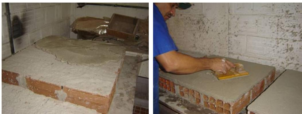
Figura 3.7 Aplicação da argamassa no painel
