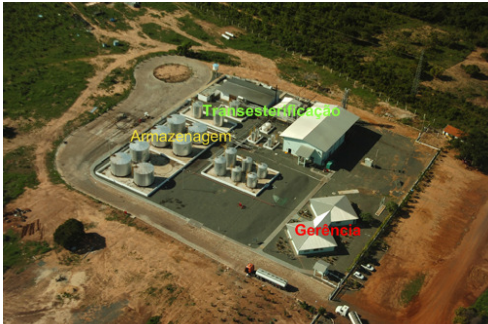
Figura 11 - Foto Aérea da Usina de Floriano
