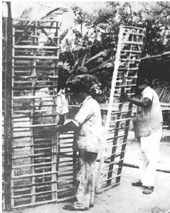
Figuras 4.24 e 4.25 Cajueiro Seco sistema pré-fabricado baseado na taipa de pilão Acácio Gil Borsoi Fonte : REVISTA PROJETO (1984)
