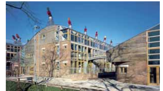
Figura 2.7 Vista externa Fonte: www.bedzed.org.uk
