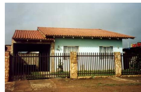
Figura 6.22 Alterações nas residências Fonte : Foto do Autor
