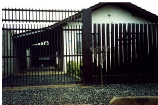
Figura 6.20 Construção de muros e gradis Fonte : Foto do Autor
