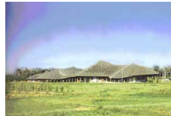
Figura 4.18 Centro de Proteção Ambiental de Balbina- AM Severiano Porto Fonte : WOLF (1998)
