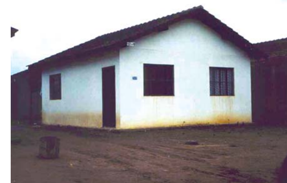
Figura 6.12 Ocupação horizontal do terreno, com casas térreas Fonte : Foto do Autor
