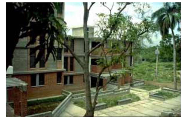
Figura 2.26 A construção respeitou os desníveis naturais do terreno Fonte: www.groundwork.org/cuba
