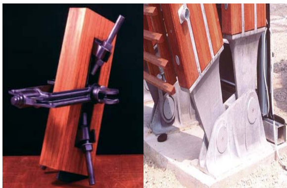
Figura 3.17 Articulações com peças de madeira e metal. Fonte : www.ipwr.org/works
