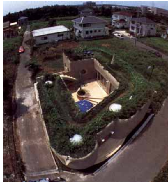
Figura 1.3 Teto jardim Soft and Hairy House, Ushida Findlay Partnership. Japão. Fonte: WINES (2000)
