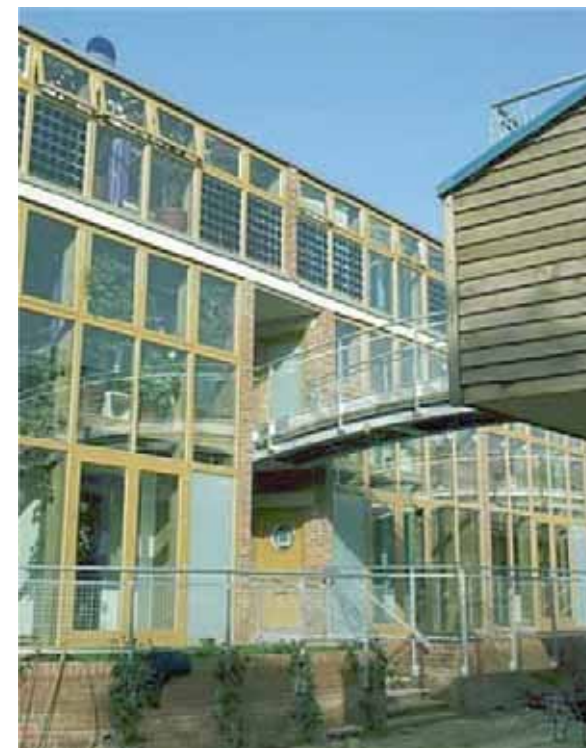
Figura 2.15 Passarelas e vidros com painéis fotovoltaicos Fonte: www.bedzed.org.uk
