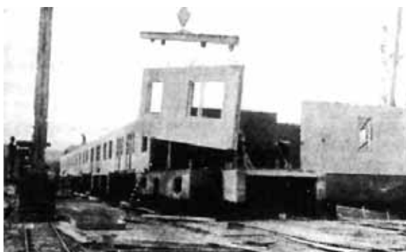
Figura 4.3 Montagem de peças industrializadas Frankfurt Fonte: BONDUKI (1998:147)
