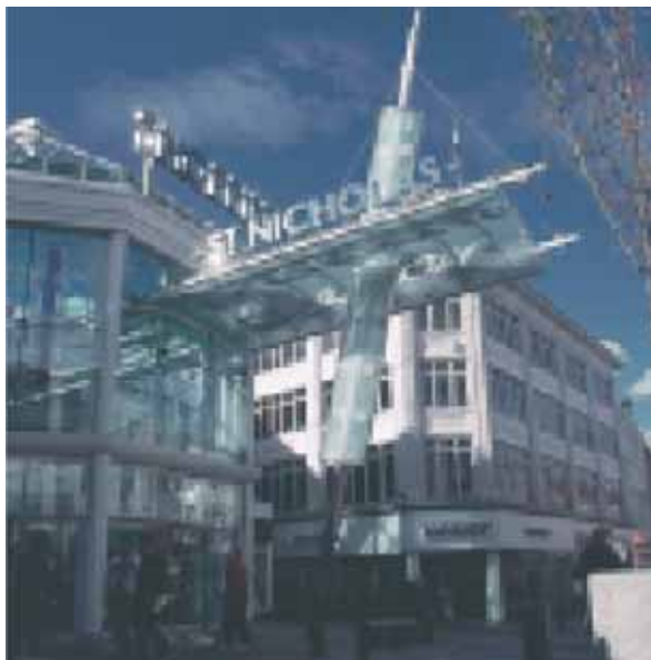
Figura 2.16 Centro Comercial Fonte: www.bedzed.org.uk
