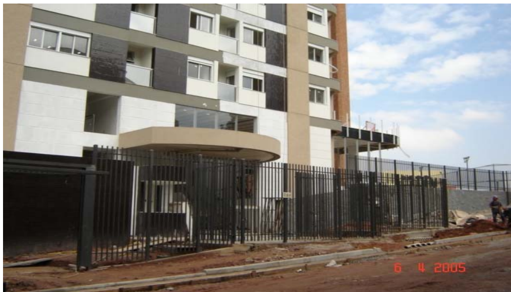
FIGURA 5.22 – Fachada com acabamento em pintura jet-cril e pastilha cerâmica Fonte: Empresa pesquisada (Obra B)
