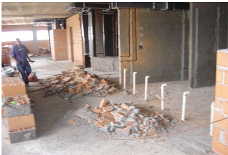
FIGURA 5.30 – Demolição de serviços acabados Fonte: Empresa pesquisada (Obra C)
