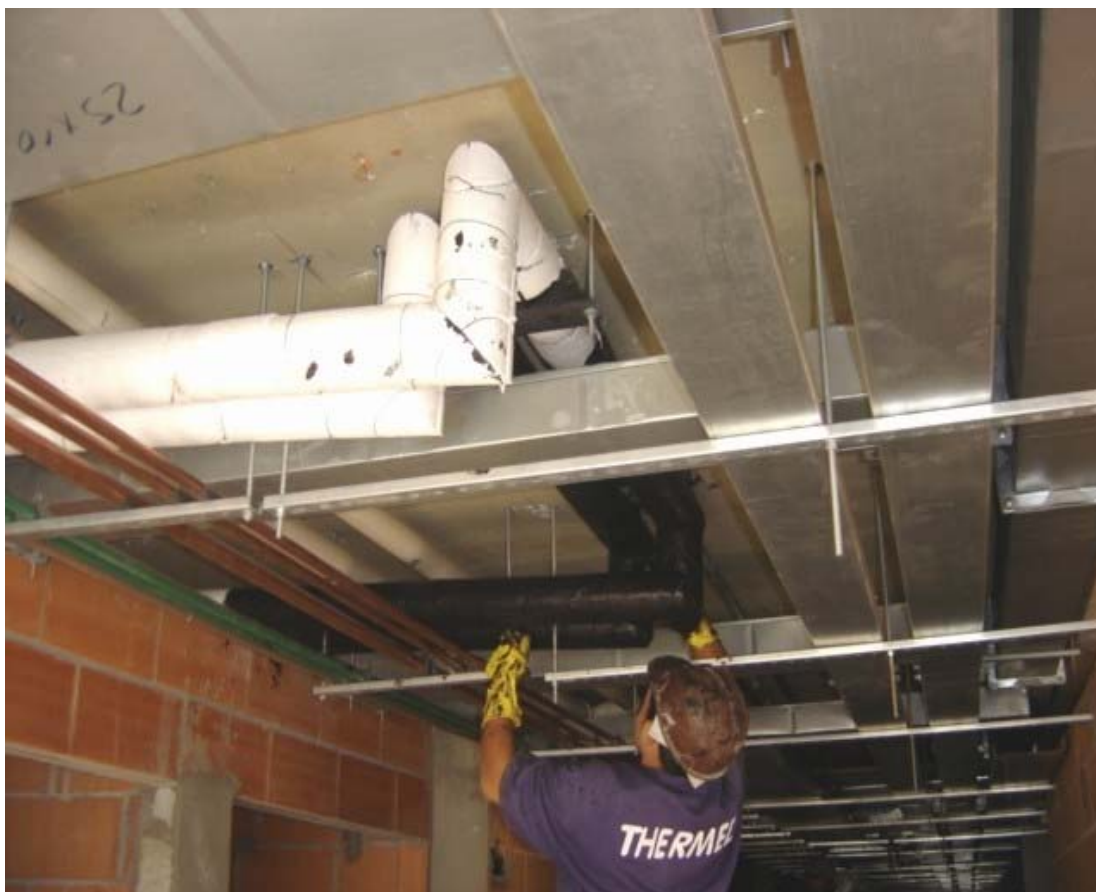
FIGURA 5.24 – Alvenaria interna com vão para passagem de tubulações, eletrocalhas e dutos Fonte: Empresa pesquisada (Obra C)
