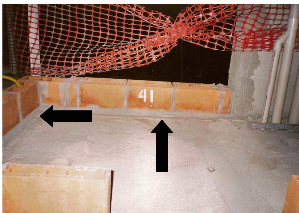
FIGURA 3.9 – Correção do nivelamento da laje na marcação da 1ª fiada
