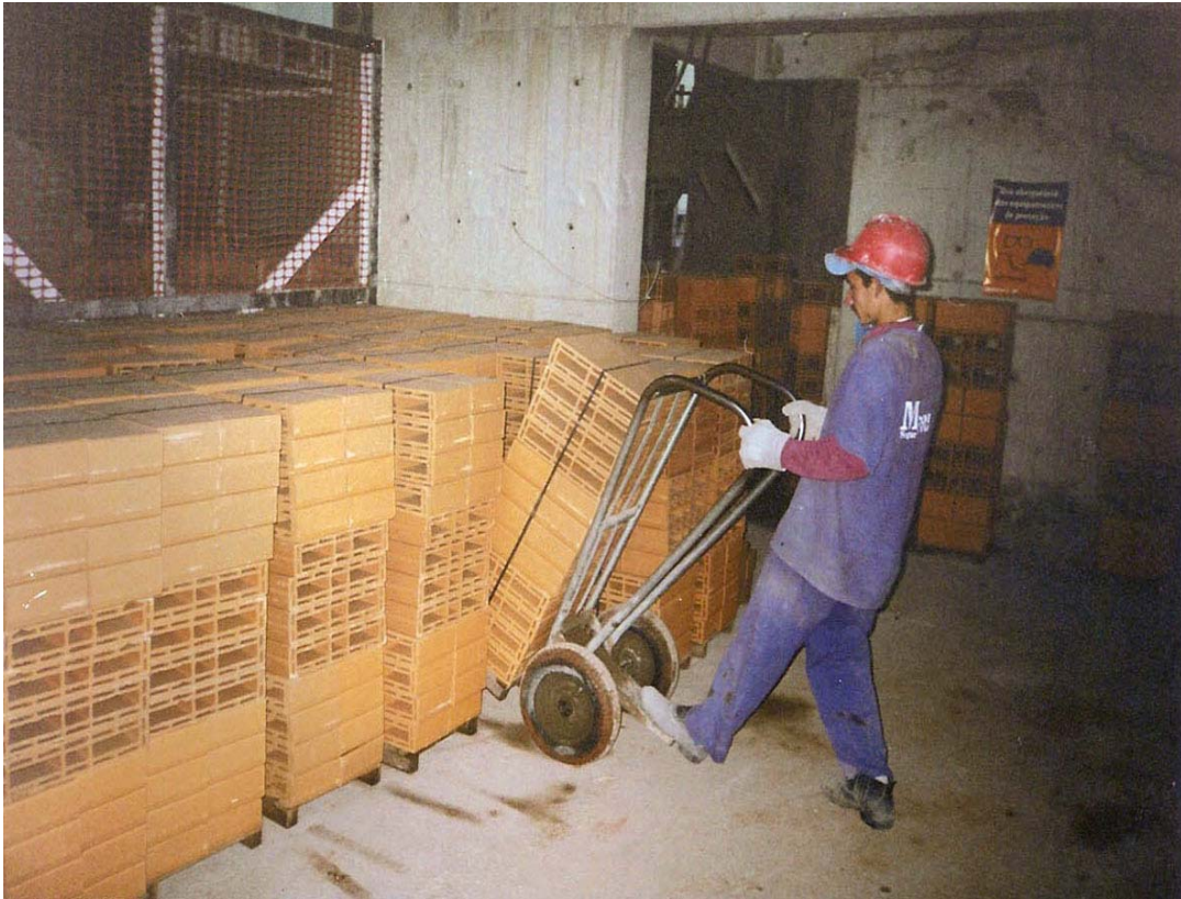
FIGURA 5.3 – Blocos cerâmicos paletizados Fonte: Empresa pesquisada (Obra A)
