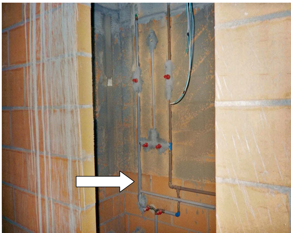
FIGURA 5.23 – Execução de ramal de distribuição antes da manta asfáltica
