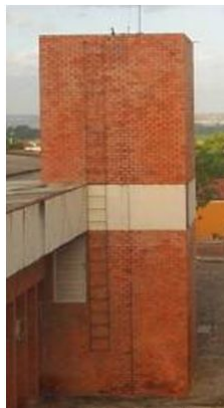
Figura 3.9 - Reservatório em concreto armado
