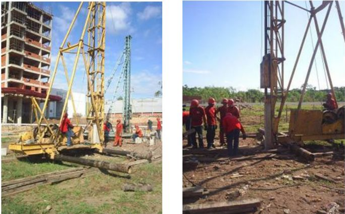
Figura 3.1 – Bate estaca em operação
