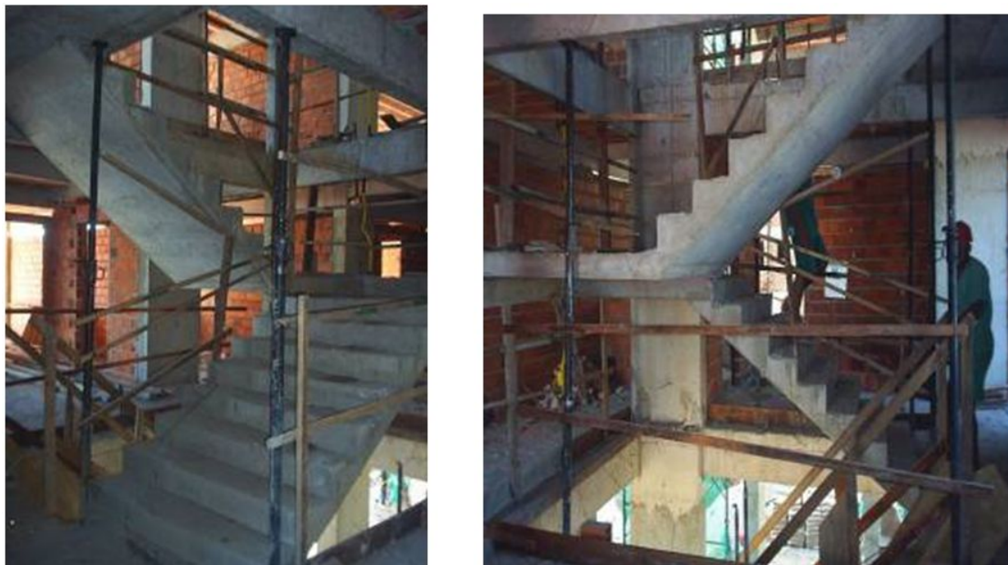
Figura 3.6 – Escada moldada in loco
