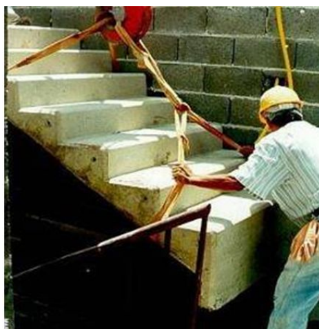
Figura 3.8 – Escada maciça pré-moldada (cortesia Eng. Fábio Nakae )
