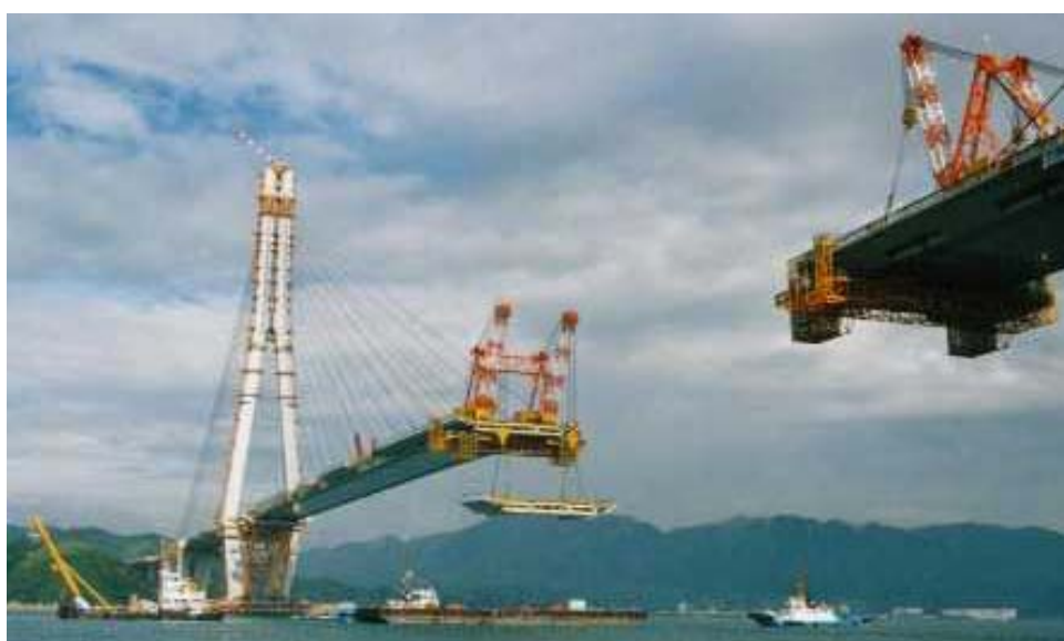
Fig. 2.18 – Ponte Tatara – Japão.
