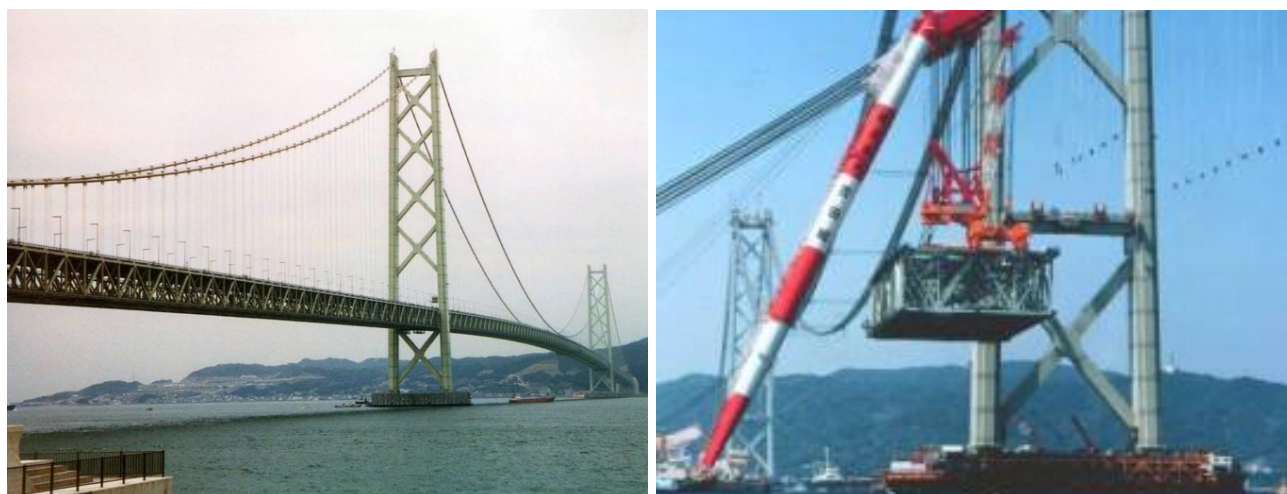
Fig. 2.13 – Ponte Akashi Kaikyo - Japão.
