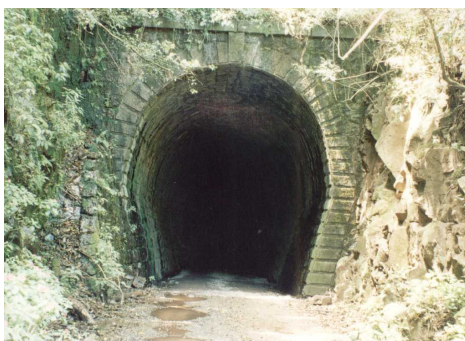
Foto 3. Entrada do Túnel de Linha Bonita
