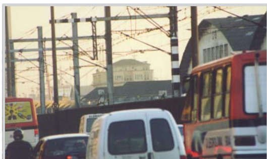
Foto 7 - Postes e muro de proteção do Trensurb visto da avenida Mauá. - Foto do Autor
