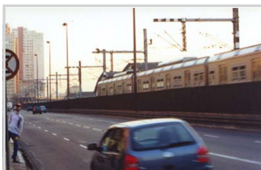
Foto 10 - Vista dos armazens do cais com a presença do Trensurb. - Foto do Autor
