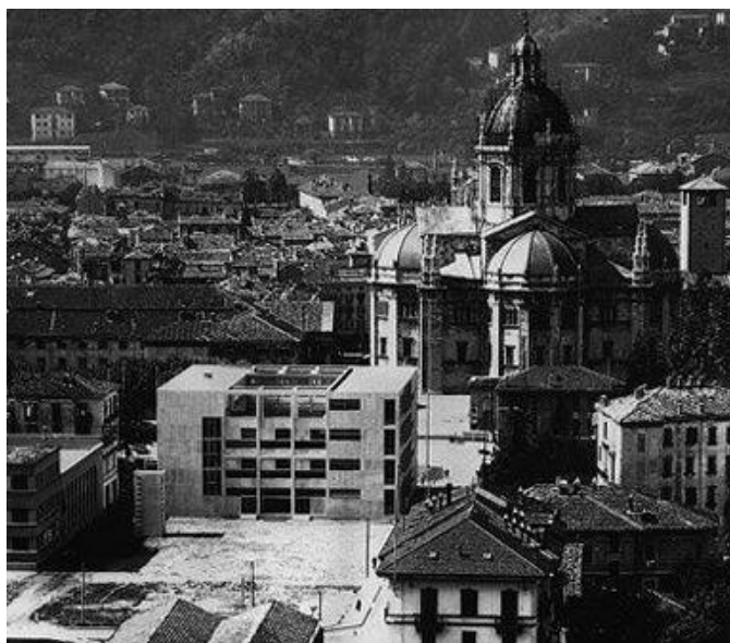
Figura 37: Casa Del Fascio , de Giuseppe Terragni, Como (1933). Vista aérea do entorno
