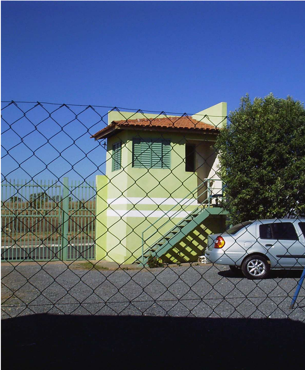
Fig. 02 – Vista da guarita da Casa de Retaguarda e do portão de acesso à rua. Foto: Elizaine Bagatelli Okde – 2007
