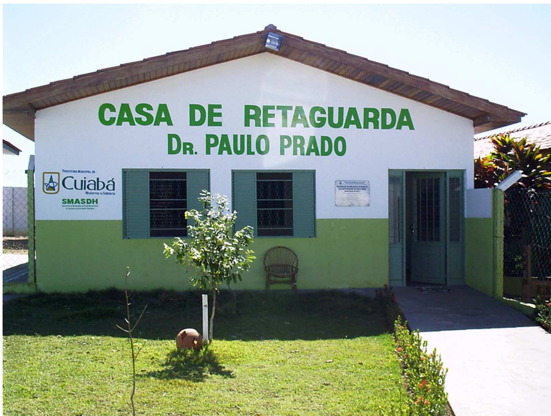
Fig. 01 – Fachada de entrada da Casa de Retaguarda Foto: Elizaine Bagatelli Okde – 2007
