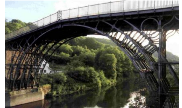
Figura 1: Ponte Coalbrookdale sobre o Rio Severn, Inglaterra [1779]. Disponível em: < http://www.lmc.ep.usp.br / people / hlinde / Estruturas / coal.htm >. Acesso em: 16 jan 2007.
