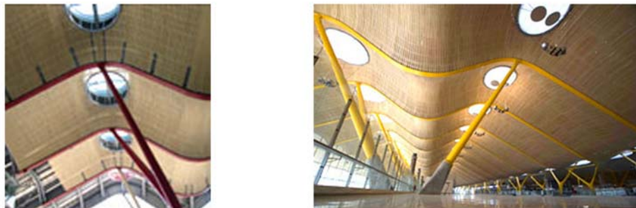
Figura 41. Cobertura do aeroporto de Madri, Espanha (Fonte: http://www.dmvpbamboo.com , 2006).
