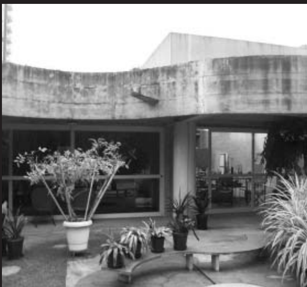
FIGURA 3.20 LAJE FINALIZA EM CURVA
