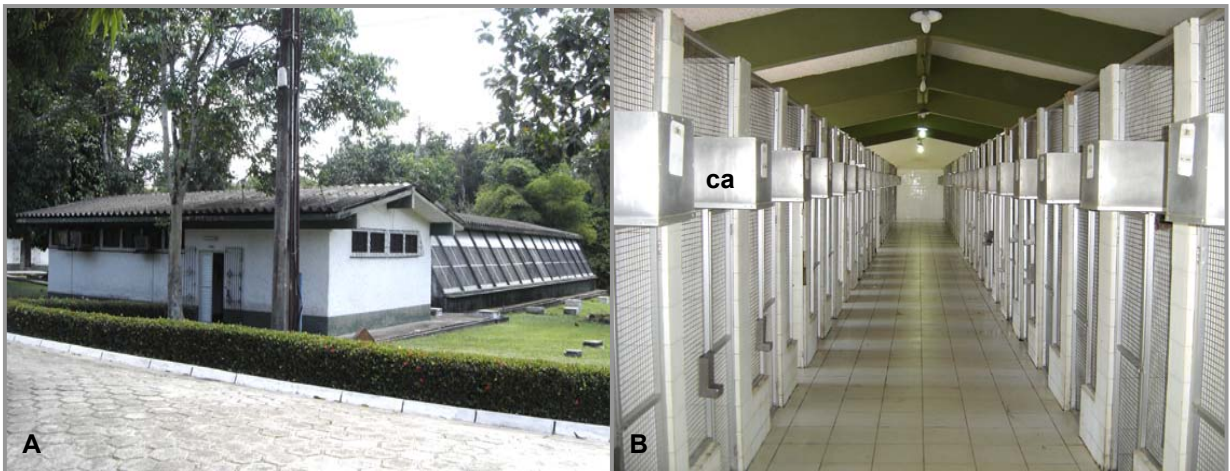
Figura 1: (A) Visão externa do galpão de reprodução I do CENP, destinado às espécies monogâmicas. (B) Recintos de alvenaria revestidos de azulejo e tela metálica, utilizados para alojar os animais, onde se evidencia a caixa abrigo ( ca ), importante durante a captura no recinto.
