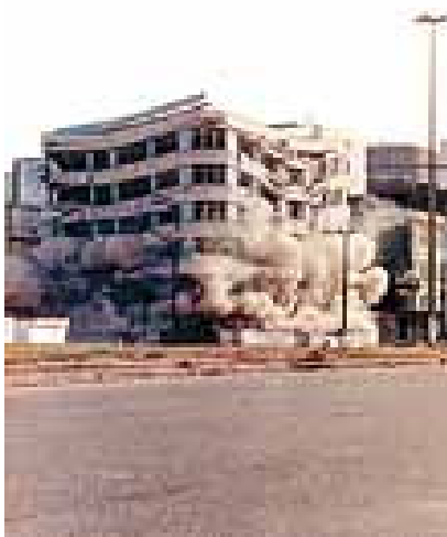
Figura 11 - Implosão do Prédio onde funcionou a Agência Miramar da Caixa Econômica Federal (05/08/1990). Fonte: AN Capital (2004).
