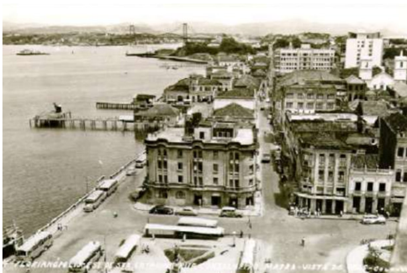
Figura 9 - Vista do Hotel La Porta em 1960 Fonte: ABREU (2004).
