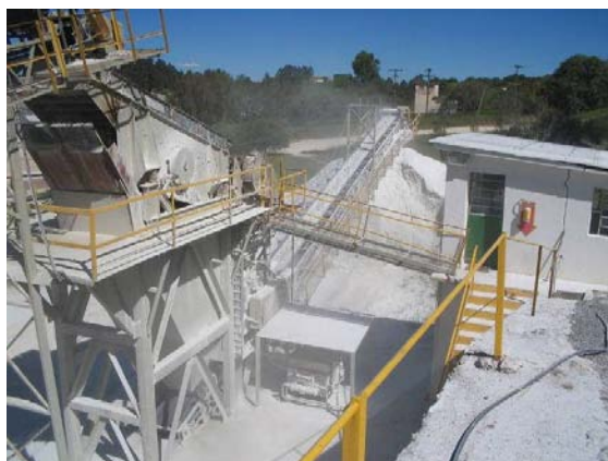
Figura 29 – Vista parcial das instalações de rebitagem
