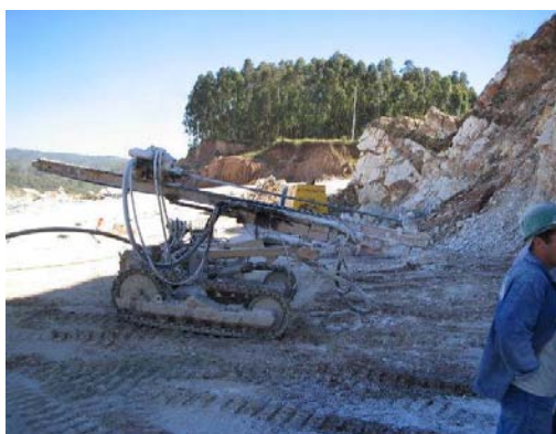
Figura 25 – Carreta de perfuração
