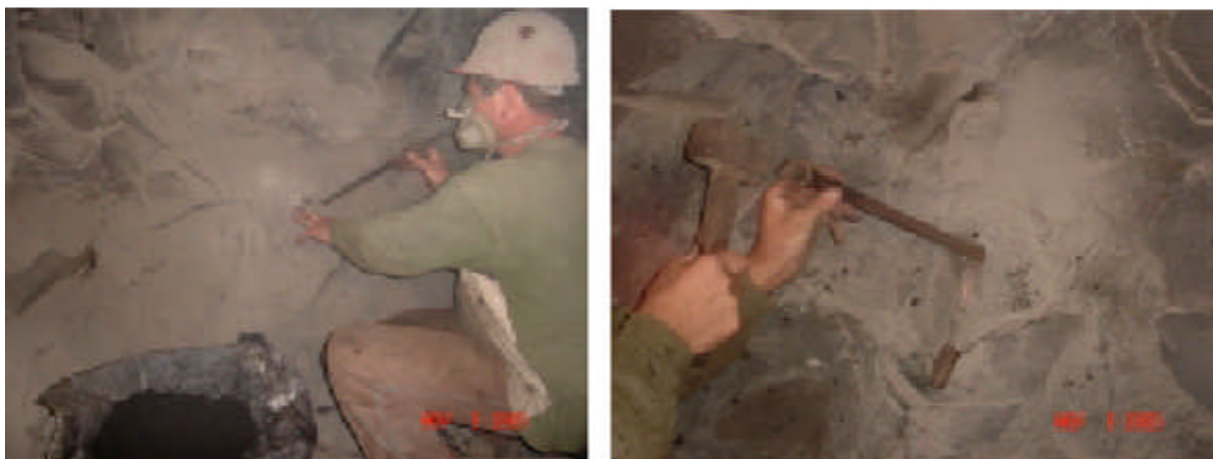
Figura 37 – Carregamento e tamponamento dos furos
