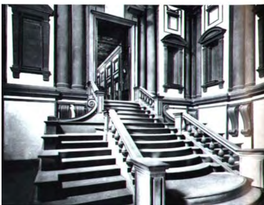
Figura 18 – Biblioteca Laurenziana – Escadas
