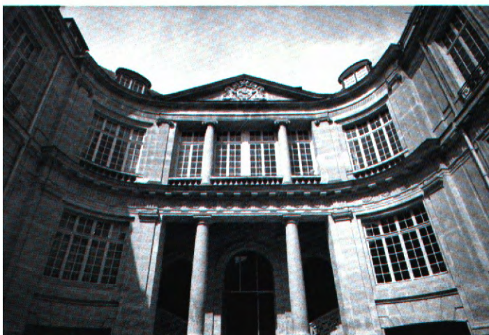
Figura 66– Hôtel Lambert: Fachada
