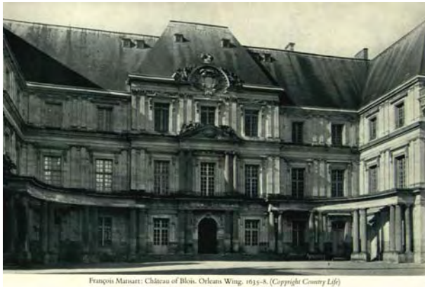
Figura 3 – Castelo de Blois – Fachada.
