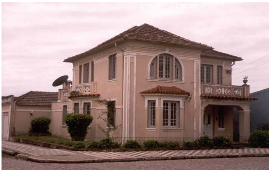
Figura 40 - Residência do Sr a Carmem Pinho Fonte: Foto de Lidiane Corrêa Ensslin
