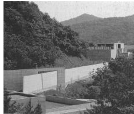
FIGURA 52: Vista do muro
