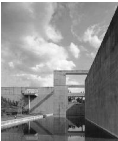
FIGURA 37: Imagem da estrutura
