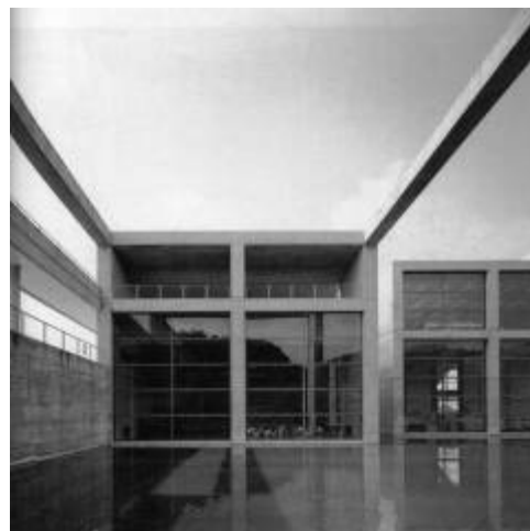
FIGURA 38: Imagem da estrutura
