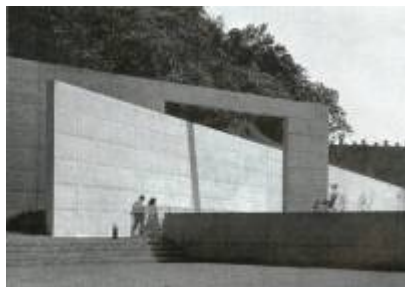
FIGURA 55: Vista do muro
