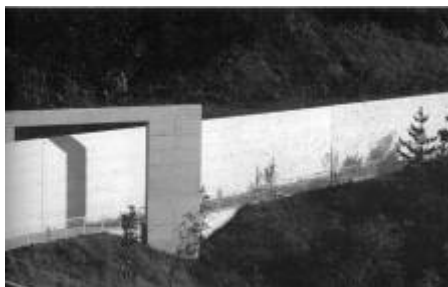
FIGURA 54: Vista do muro
