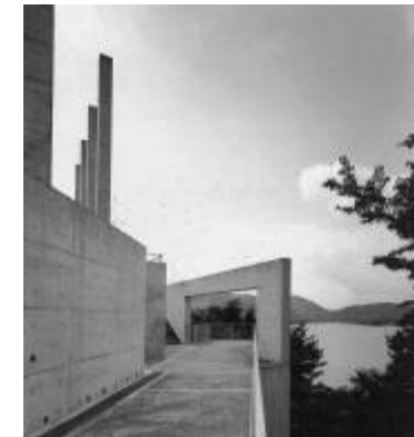
FIGURA 53: Vista do muro
